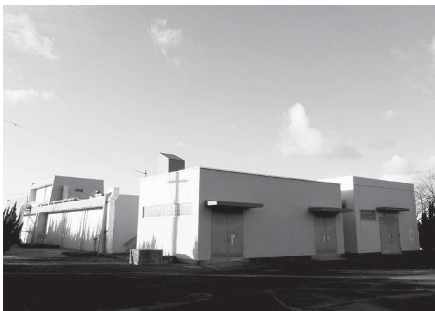
光明台高区配水場
