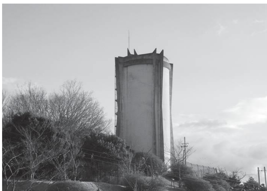
光明台高区配水塔
