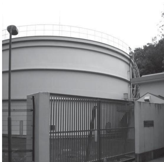
テクノステージ配水池
