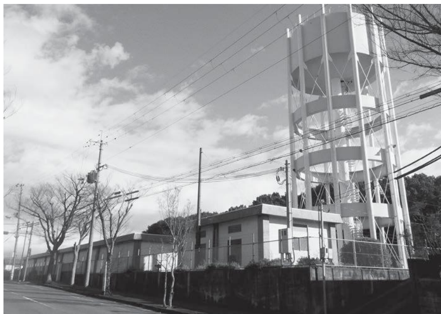
鶴山台配水場
