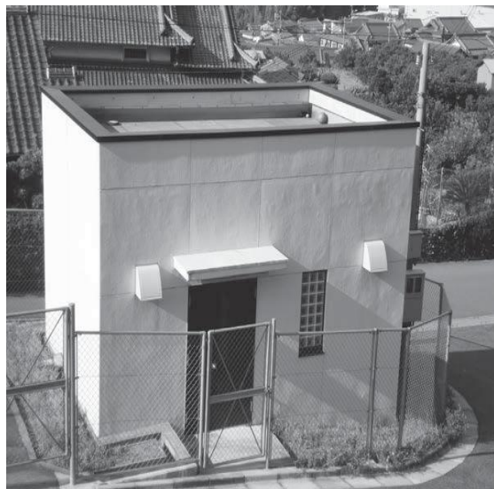
坪井加圧ポンプ所
