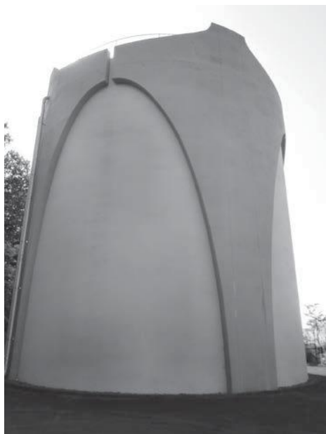
みずき台配水塔
