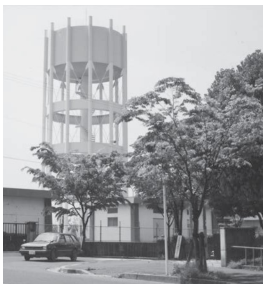
鶴山台配水場
