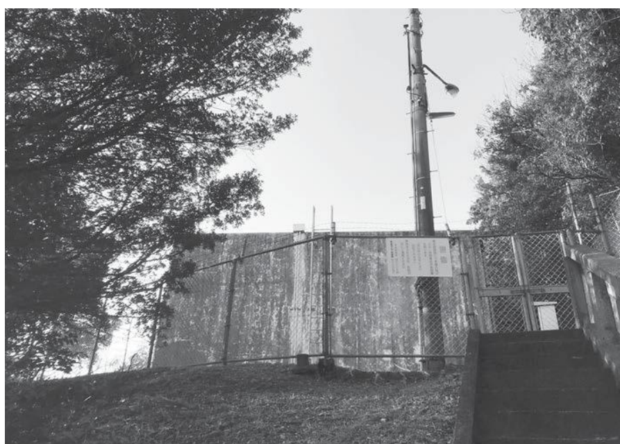
南面利配水池
