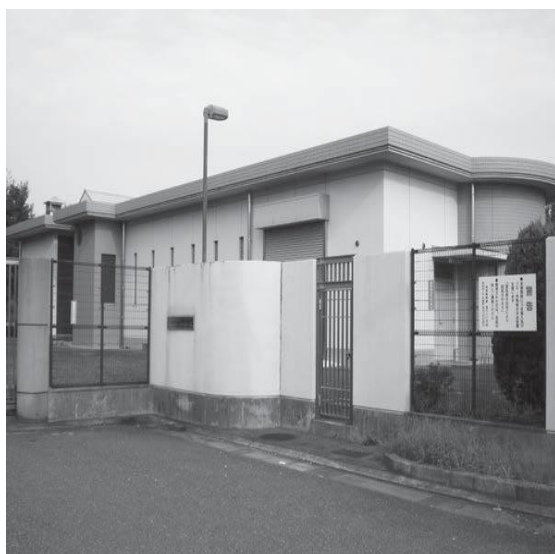
テクノステージ加圧ポンプ場
