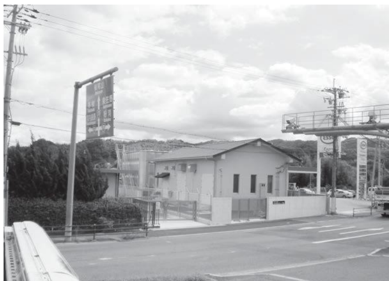
仏並加圧ポンプ場
