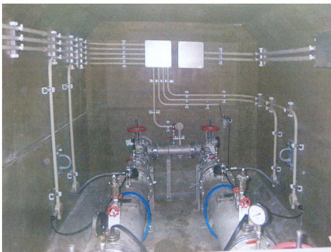
図-10 完成写真（ユニット内部）
