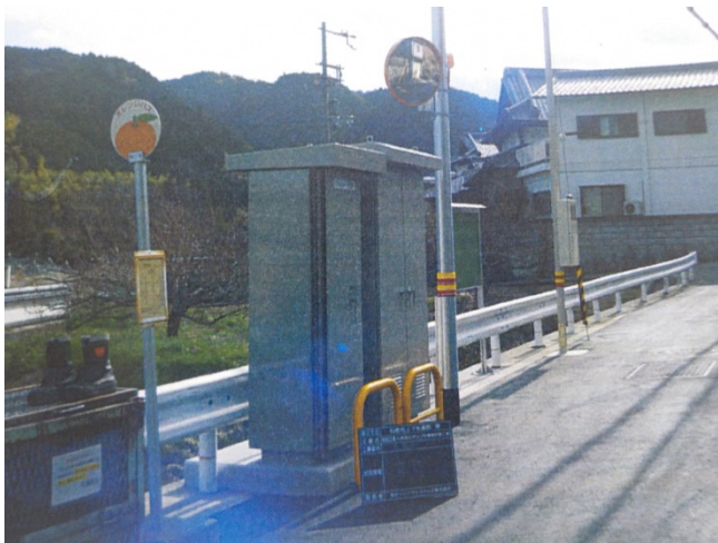
図-9 完成写真（地上）
