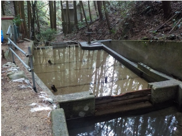
図-3 九鬼簡易水道（ろ過池）
