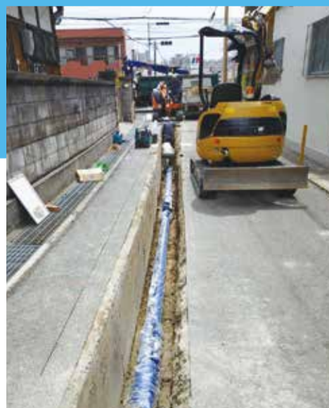
水道管布設工事
